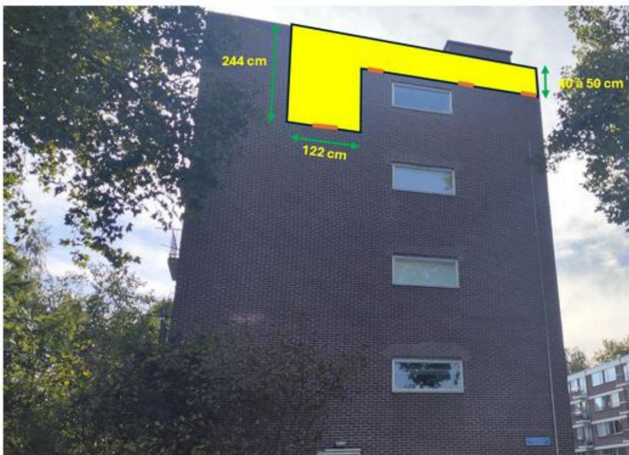
Figuur 6: Maatwerkvoorziening voor gewone dwergvleermuis. Op beide kopgevels wordt een boeiboordconstructie gerealiseerd.
