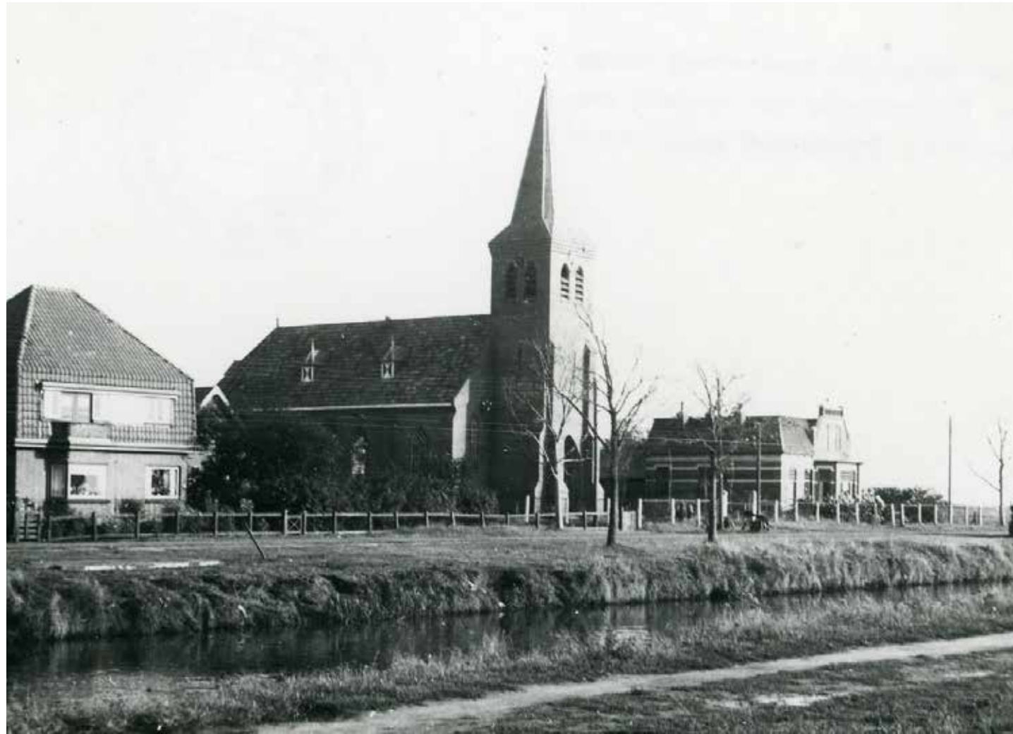
Figuur 3: De Veenkerk van Klazienaveen-Noord. Een goed voorbeeld van een traditionele zaalkerk zoals deze vaak voorkwamen aan het einde van de negentiende en het begin van de twintigste eeuw. (bron hierkomjijweg.nl)
