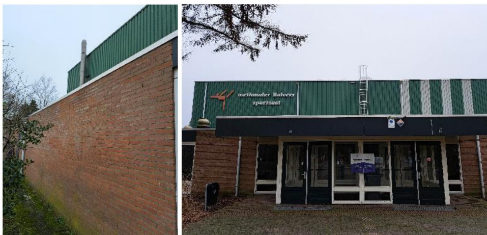
Figuur 1.2 Impressie van de bebouwing binnen het plangebied. Foto's: Ecogroen
