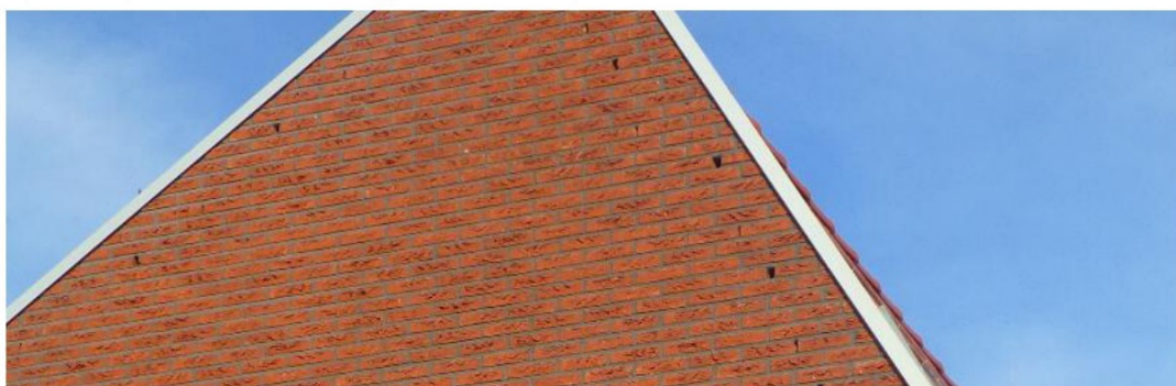
Figuur 6.4 Het realiseren van gebouwen met een toegankelijke spouw via open stootvoegen is voor gebouwbewonende vleermuizen vaak de beste optie. Bron: Ecogroen.
