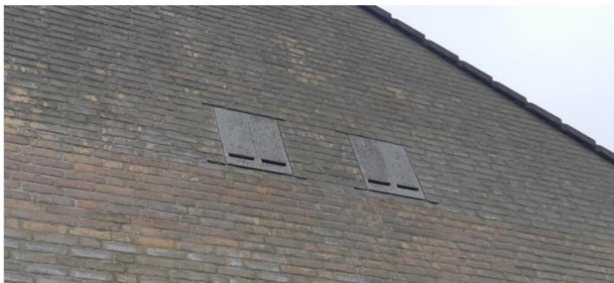
Figuur 6.3 Ingemetselde vleermuisverblijfplaatsen. Bron: Ecogroen.
