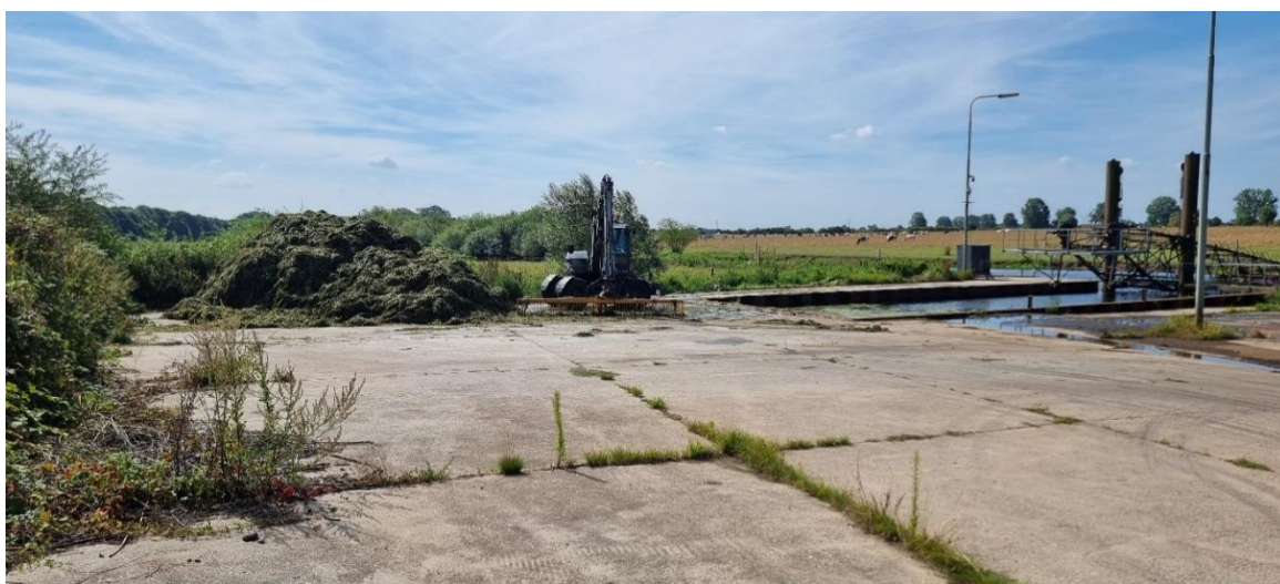
Figuur 2. Huidige vuilvanginstallatie bij de Niers.
