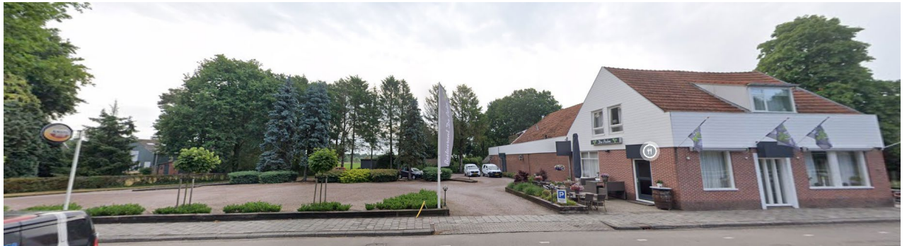
Figuur 2 Huidige situatie (Bron: Google Street View)
