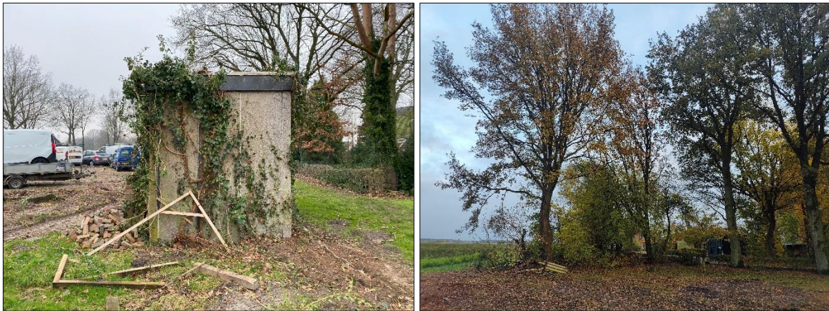
Foto links: opgeslagen materialen naast transformatorhuis. Foto rechts: (bos)struweel geschikt voor wezel.
