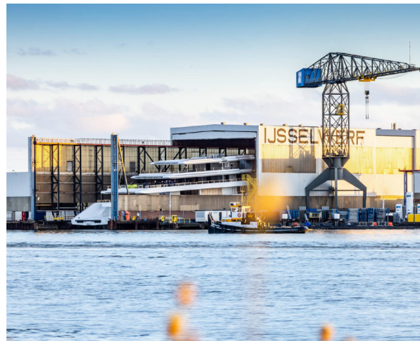
afbouwloods van de IJsselwerf aan de IJsseldijk, gezien in zuid-oostelijke richting (bron: https://zwijnenburgyachting.com/ ).
