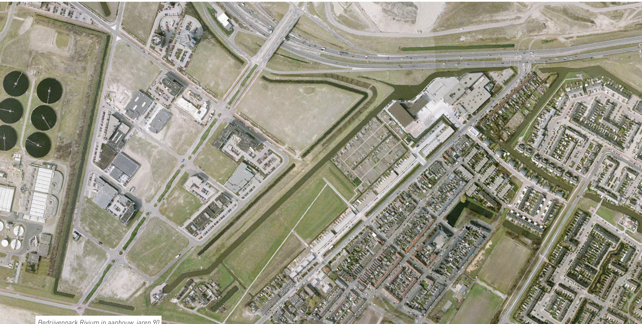
Bedrijvenpark Rivium in aanbouw, jaren 90
