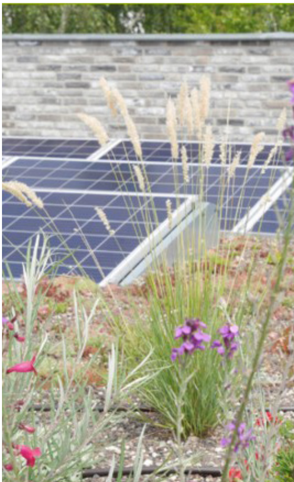
Klimaat adaptief dak gecombineerd met zonnepanelen (foto: natuurbijhuis).
