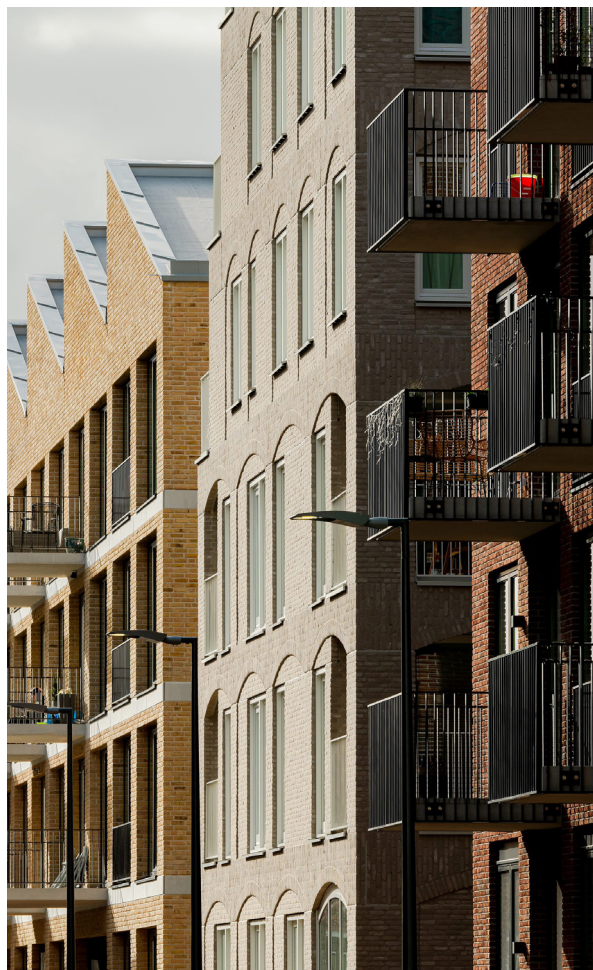
Gebouwen hebben een afwisselend karakter; Strijp S, Ingenieur Kalfstraat, Eindhoven, Nederland, door Inbo (foto: Sebastian van Damme)
