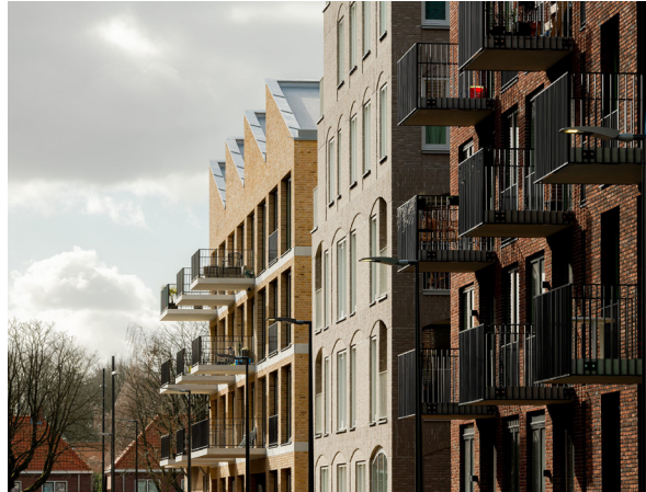
Gebouwen hebben een afwisselend karakter; Strijp S, Ingenieur Kalfstraat, Eindhoven, Nederland, door Inbo (foto: Sebastian van Damme)
