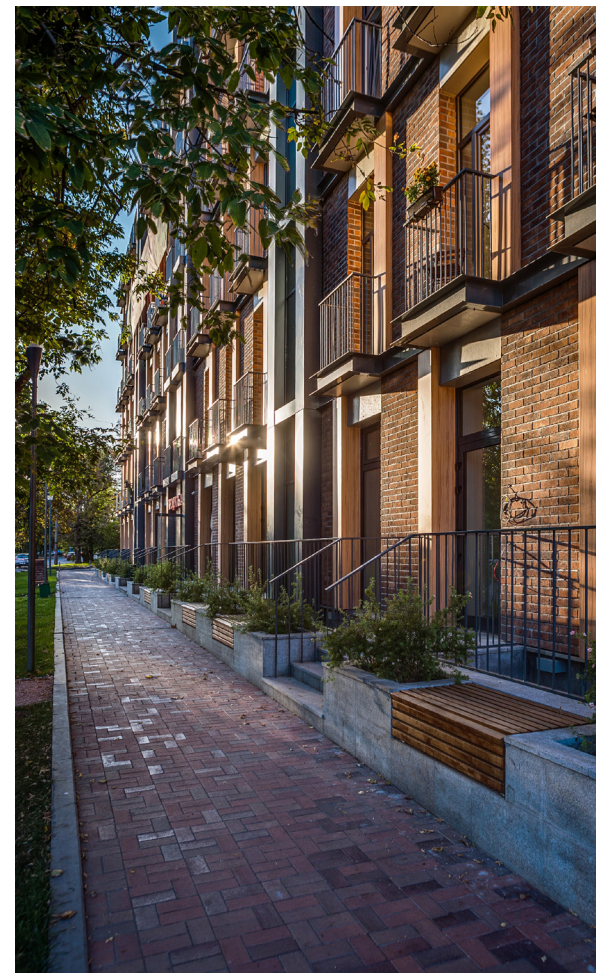
Helder ontworpen overgangszones tussen privé en openbaar; Berzarina street, Moskou, door ADM Architects (foto: © ADM Architects / Anatoliy Shostak)
