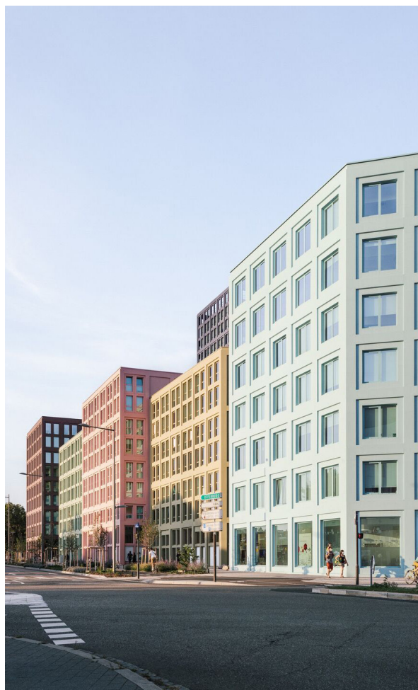
Ieder bouwblok is duidelijk herkenbaar in uitstraling en massa opbouw; Nollistra, Straatsburg, door Lan and TOA (foto: Charly Broyez)
