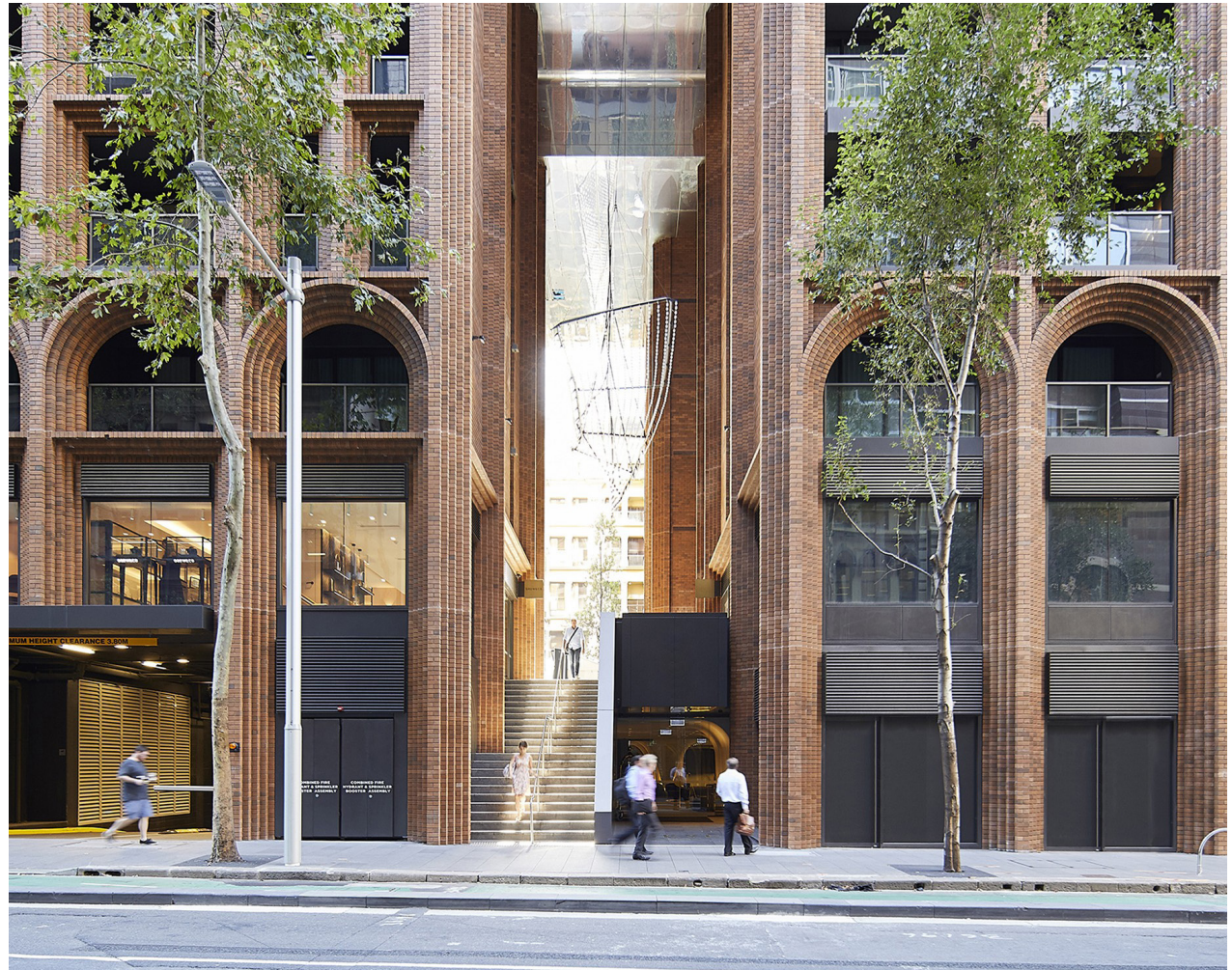
Entrees, openbaar gebied en trap naar binnenhof zijn in samenhang ontworpen; Arc, Sydney, Australia, door Koichi Takada Architects (Foto: Martin Mischkulnig)
