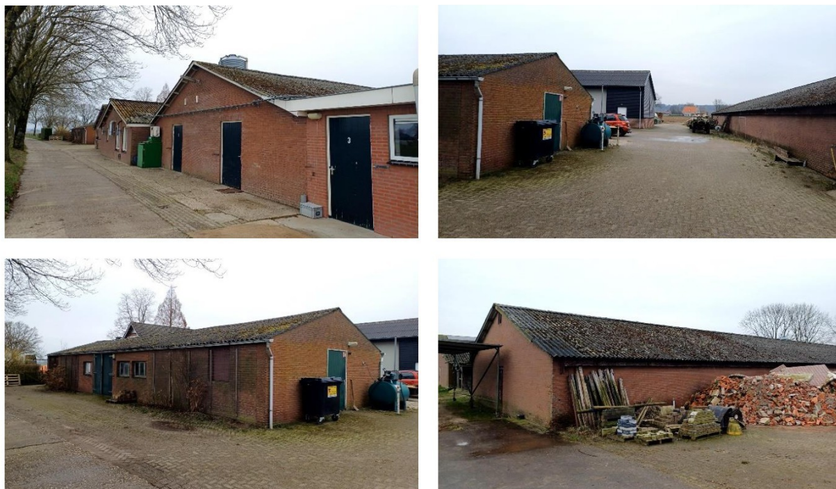
Figuur 2. Weergave van delen van het plangebied. Linksboven: te slopen stallen vanaf zuidoosthoek. Rechtsboven: doorgang tussen schuur en stal 1. Linksonder: schuur. Rechtsonder: noordwesthoek van plangebied met stal 1. Bron: rapportage Quickscan.
