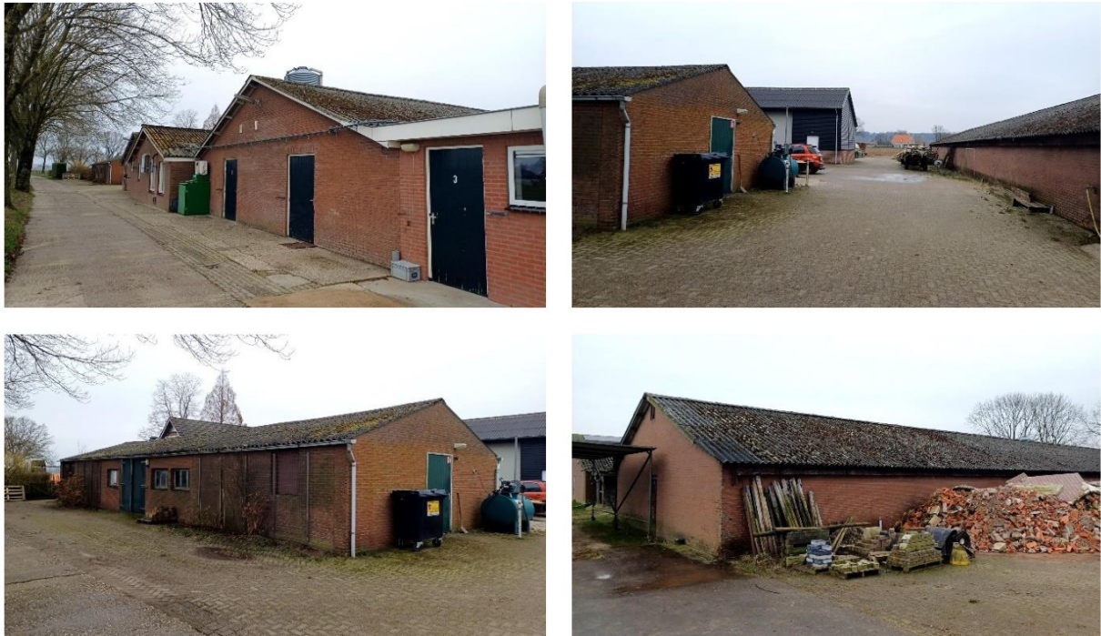
Figuur 2. Weergave van delen van het plangebied. Linksboven: te slopen stallen vanaf zuidoosthoek. Rechtsboven: doorgang tussen schuur en stal 1. Linksonder: schuur. Rechtsonder: noordwesthoek van plangebied met schuur 1.
