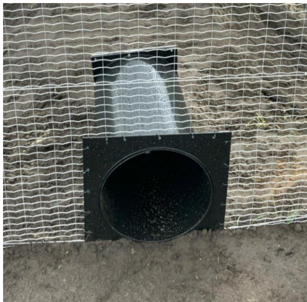
Afbeelding 3. Voorbeeld van een dassenpoort. In dit voorbeeld wordt een rechte poort gebruikt, in de praktijk wordt gebruik gemaakt van poorten met een bocht.
