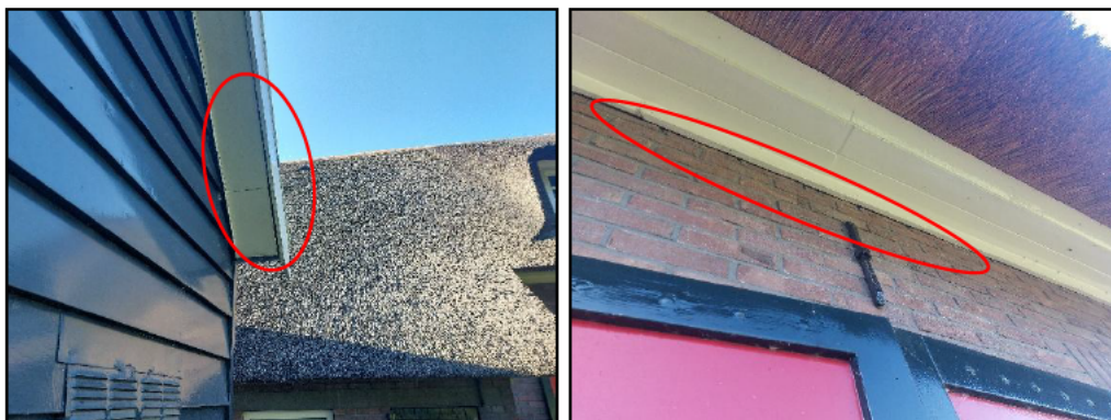
Figuur 2.5. Er zijn meerdere openingen in de bebouwing aangetroffen waar vleermuizen achter weg kunnen kruipen. Bron: Antea Group, 2025.
