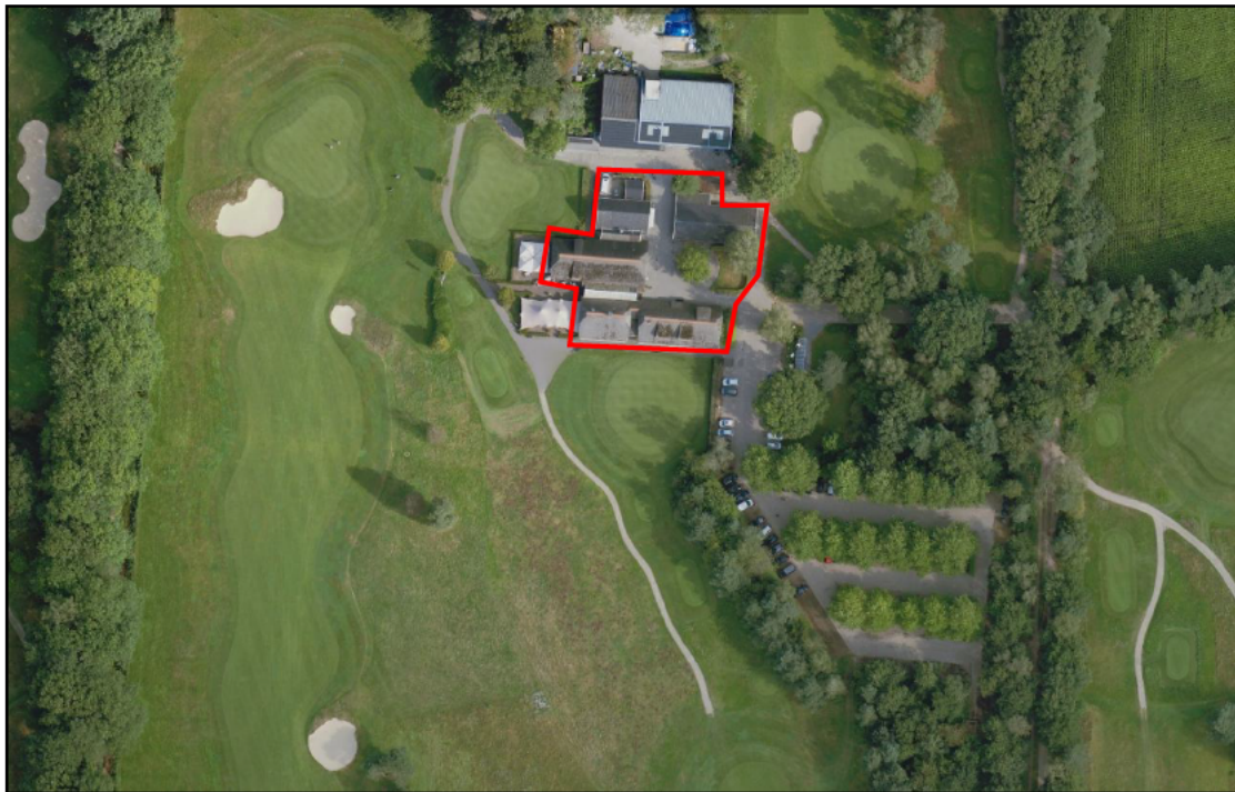
Figuur 1.2. Gedetailleerde ligging van de gebouwen die worden gesloopt (rood omkaderd). Bron: Streetsmart, 2024.
