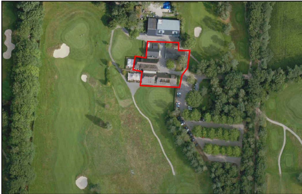
Figuur 1.1. Gedetailleerde ligging van de gebouwen die worden gesloopt (rood omkaderd). Bron: Streetsmart, 2024 en Antea Group, 2025.
