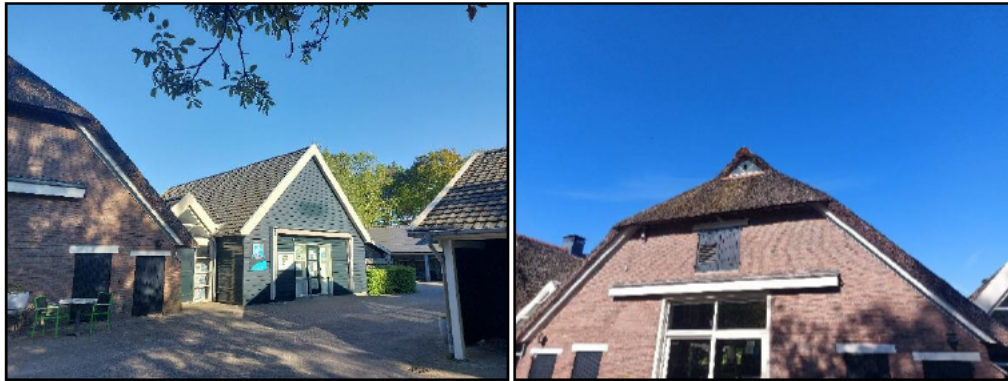
Figuur 1.2. Enkele foto's van de te slopen gebouwen. Bron: Antea Group, 2025.
