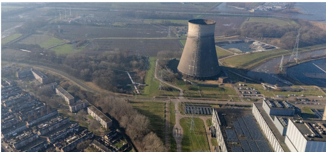
Figuur 8. Overzicht van dijktraject Geertruidenberg-Noord. Op de voorgrond de woonwijk Geertruidenberg-West en de Amercentrale. Op de achtergrond het Amergebied. Op de afbeelding is het dominante karakter van de Amercentrale goed te zien. Ook ligt de Amercentrale duidelijk tegen de dijk van Geertruidenberg-Noord aan.
