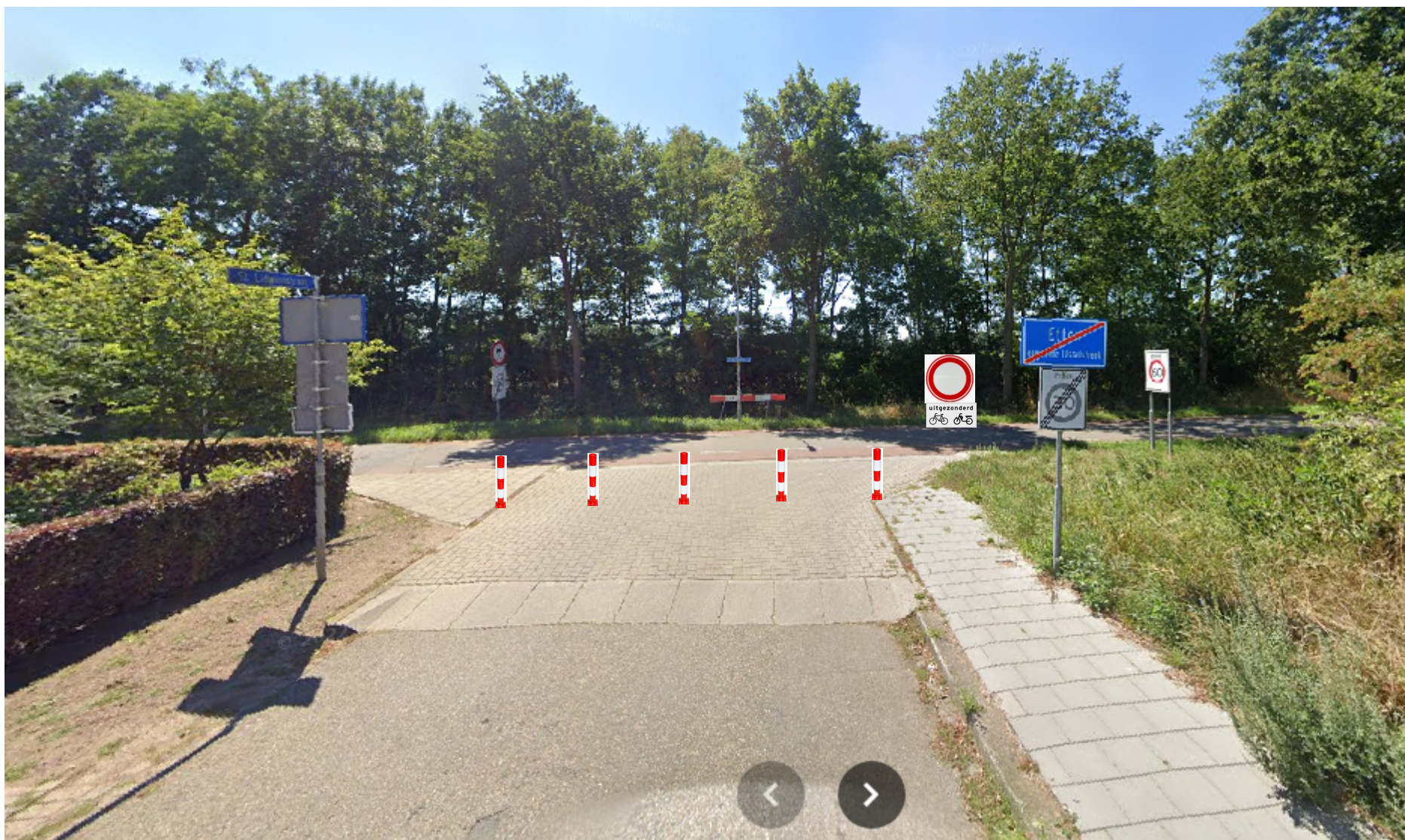
afbeelding 2 afsluiting St. Lidwinastraat gezien vanuit de St. Lidwinastraat
