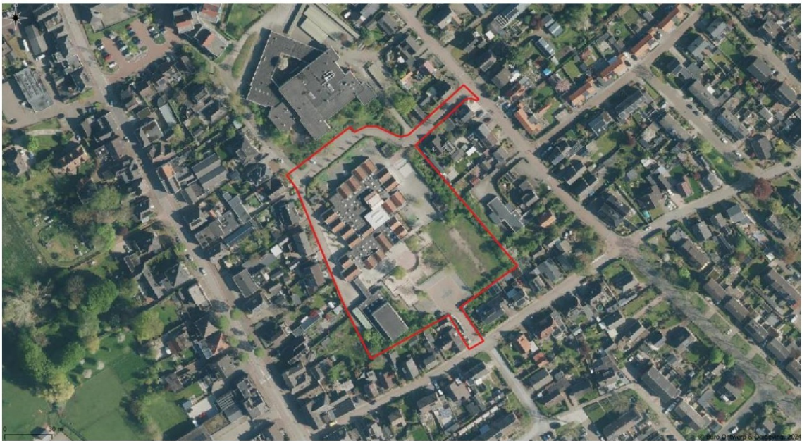
Figuur 1. Luchtfoto van het plangebied aan het Pastoor Bluemersplein te Silvolde (rood kader).
