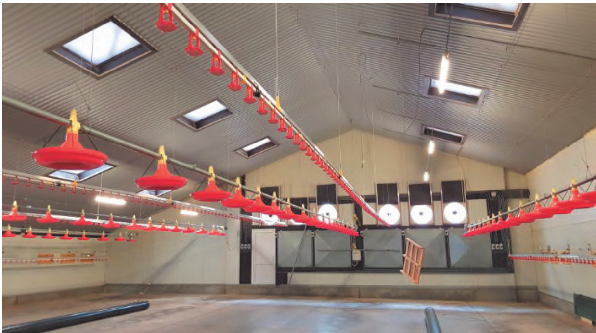
Binnenstal met voer- en drinkwaterlijnen, verwarming, daglicht en mechanische ventilatie
