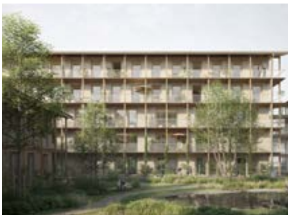
De galerij appartementen zijn in een warme, lichte tint uitgevoerd. Hiermee oogt de massa niet te fors.
