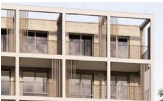
Mee ontworpen balustrade voor balkons en gallerijen. Balustrade speelt in op kleur en materiaalgebruik van gevel en harmonieert hiermee. Ook brandtrappen, kozijnen, zonwering en installaties volgen dit principe
