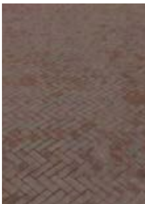
rijbaan 6 meter gebakken klinkers, dikformaat keperverband, roodbruin genuanceerd
