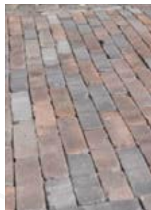
trottoir Twentse erf 1.80m gebakken klinkers, hergebruik, halfsteensverband, roodbruine tint met blauwe accenten
