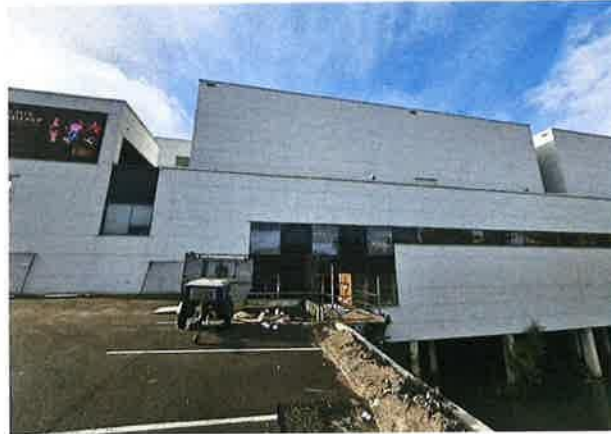
Figuur 5: Zijgevel naastgelegen bebouwing
