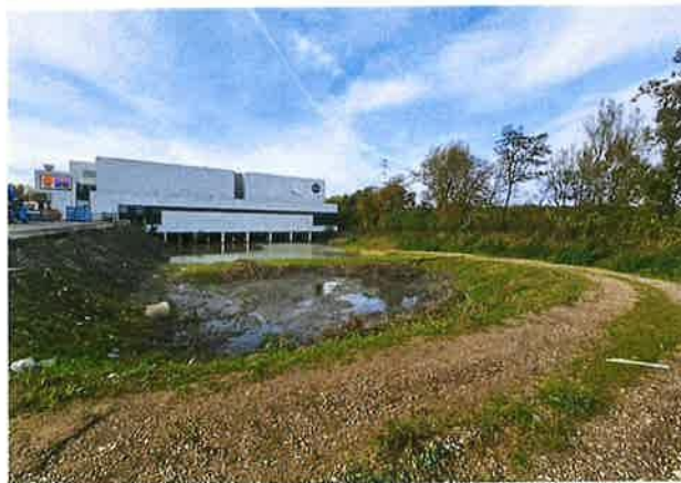
Figuur 7: Plangebied gezien vanuit het oosten
