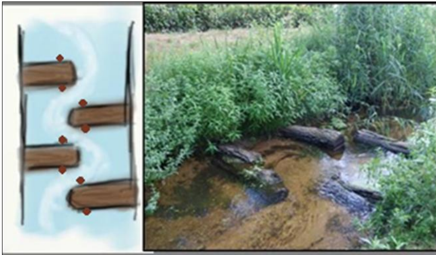
Constructie stammen in de beek.
