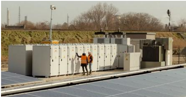
Figuur 2.2: Voorbeeld vormgeving batterijen in losse containers (Bron: Solar Magazine, 2023)
