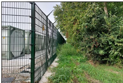
Figuur 4.10. Noordelijk bosperceel, met aangrenzend hekwerk hoogspanningsstation.
