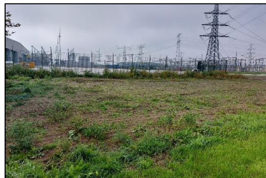
Figuur 4.13. Aangrenzend braakliggend terrein westzijde Hoogspanningsstation
