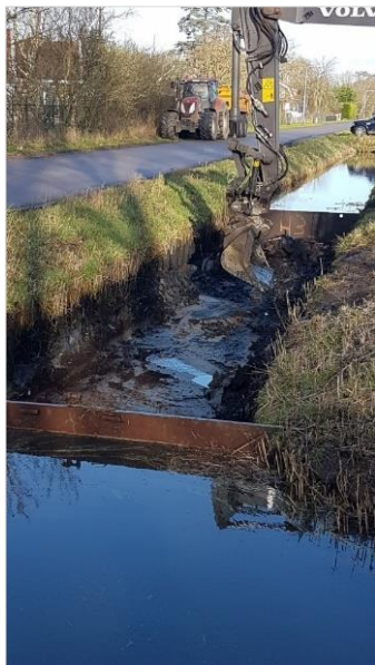
Figuur 4.17 Afdammen werklocatie.
