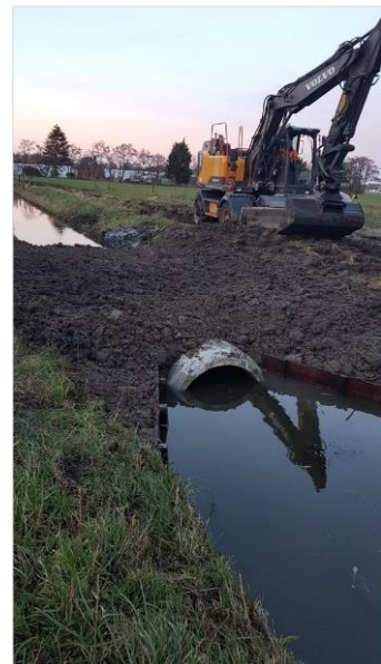
Figuur 4.19 Duiker afdichten met aarde en dammen verwijderen.
