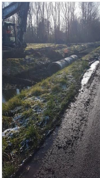
Figuur 4.18 Plaatsen duiker en damwanden.
