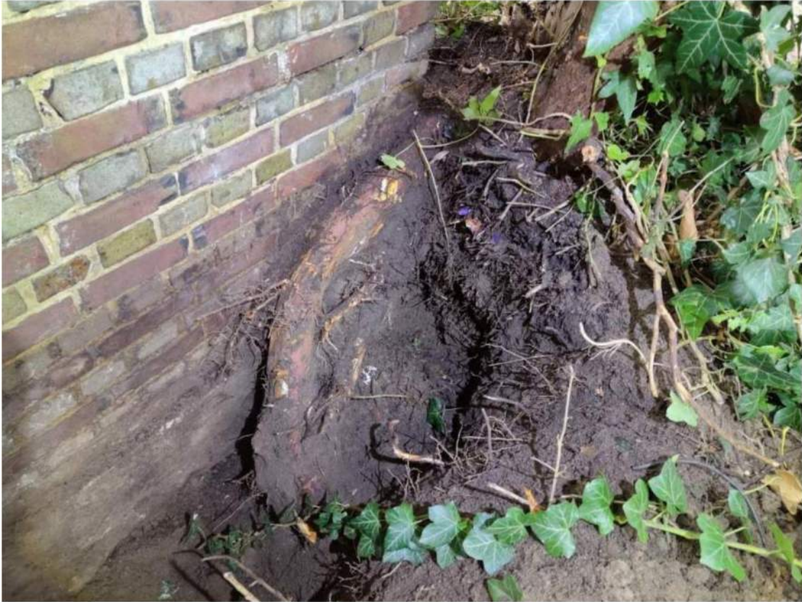
Wortelgroei aan linker achterzijde van bank (gezien vanaf achterzijde).
