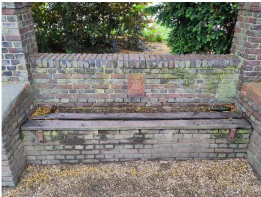
ZO (9): overblijfselen van de houten afwerking van de zitting.
