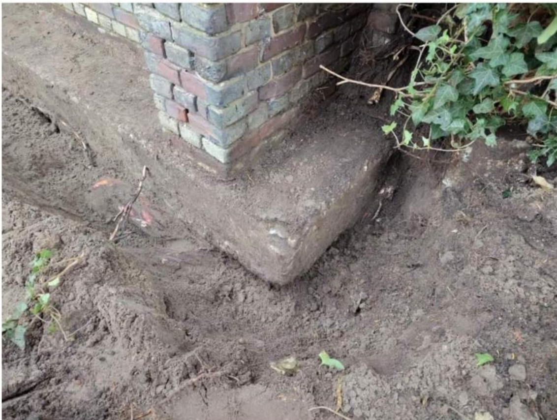
Wortelgroei aan rechterzijde en voorzijde van de bank.
