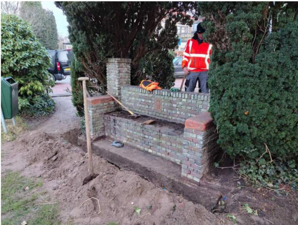
Graafwerkzaamheden aan voorzijde van de bank.
