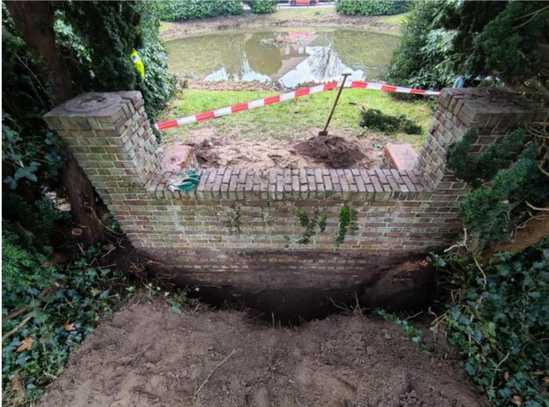
Graafwerkzaamheden aan achterzijde van de bank.
