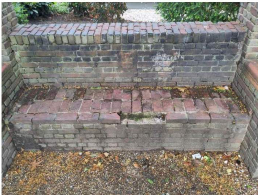
ZW (11): ontbreken van bakstenen aan de voorzijde van de zitting.
