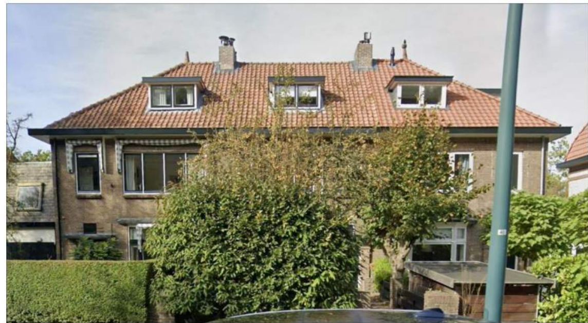
voorbeeld overgang dakvlakken met hoekpan (Warmonderweg 40-42)
