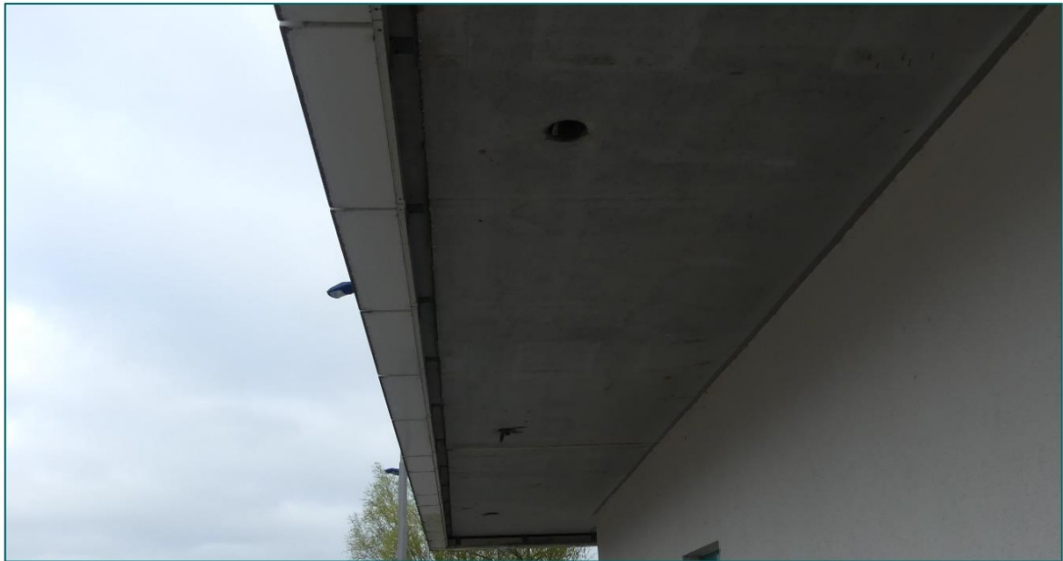
Figuur 3.1 Openingen aan de onderzijde van de bebouwing welke loodrecht naar boven gericht staan. Doordat zich aan de binnenzijde van de openingen Pvc-buizen bevinden en de openingen loodrecht omhoog staan, kunnen deze openingen niet door vleermuizen gebruikt worden om de bebouwing te betreden.
