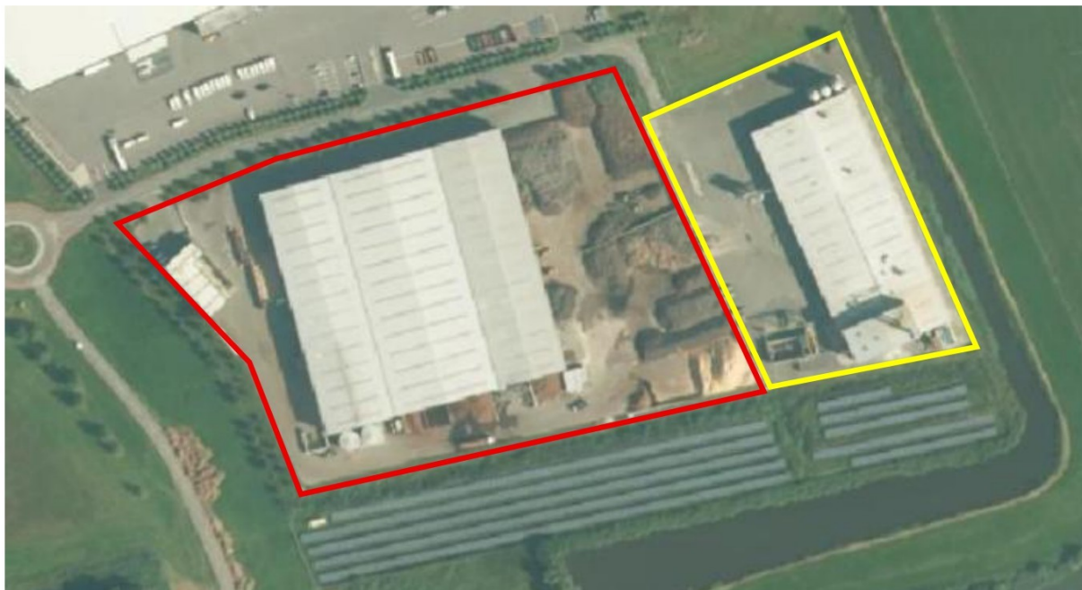
Figuur 1, Locatie composteerinrichting (rood omlijnd) en Biomassacentrale (geel omlijnd) te Duiven.
