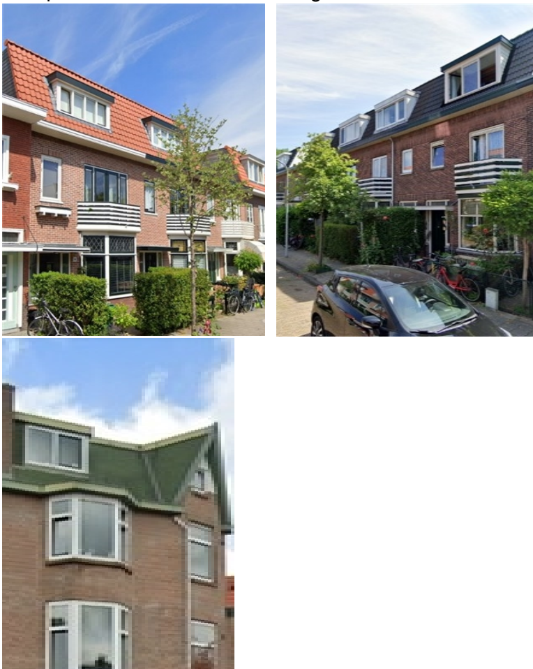
Links en midden twee kleuren keramische dakpannen op dakopbouwen in dezelfde straat op verschillende gebouwensembles. Rechts een dakbedekking van groene shingles – deze kleur past niet binnen de uitgangspunten van dit beeldkwaliteitsplan.
