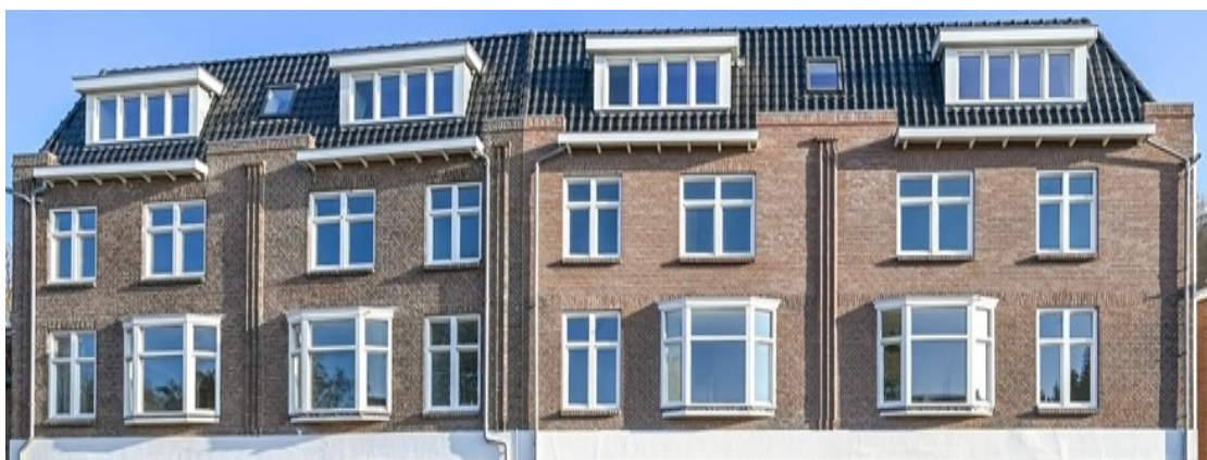
Deze dakopbouwen illustreren goed hoe details van de gevelbeëindiging zoals de opgetrokken geveldelen tussen de goten zorgvuldig kunnen worden doorgezet.
