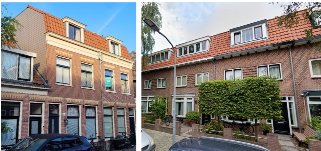
Links een dakopbouw met mansardekap waarvan een deel als plat dak is uitgevoerd. Als alle dakopbouwen in de loop ter tijd zijn geplaatst, is het platte dakdeel niet langer zichtbaar vanuit de straat. Rechts dakopbouwen met een afgeknotte schuine kap en een hellingshoek van 70 graden.
