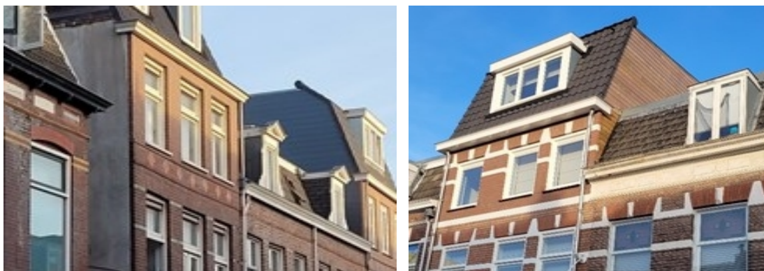
Het linker beeld laat een voorbeeld zien van een dakopbouw waar een kopie van de oorspronkelijke vorm van de goot overgenomen is als nieuwe gewelbeëindiging. Het rechterbeeld laat een dakopbouw zien waarvan de vorm van de goot niet overeenkomt met de originele goot (te zien aan het pand rechts van het pand met de dakopbouw) Tevens ontbreekt de kenmerkende lijst.
