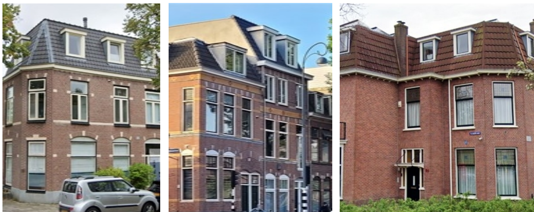
Links een voorbeeld van een dakopbouw die een afgeschuinde gevel volgt met een dakkapel met een grijze zijkant. Ook de dakkapellen zijn goed uitgelijnd ten opzichte van onderliggende vensters. Midden een dakopbouw met een 70-gradenkap en een zijkant die is voorzien van grijs pleisterwerk. Rechts een schuine kap die de contouren van de hoofdgevel volgt.
