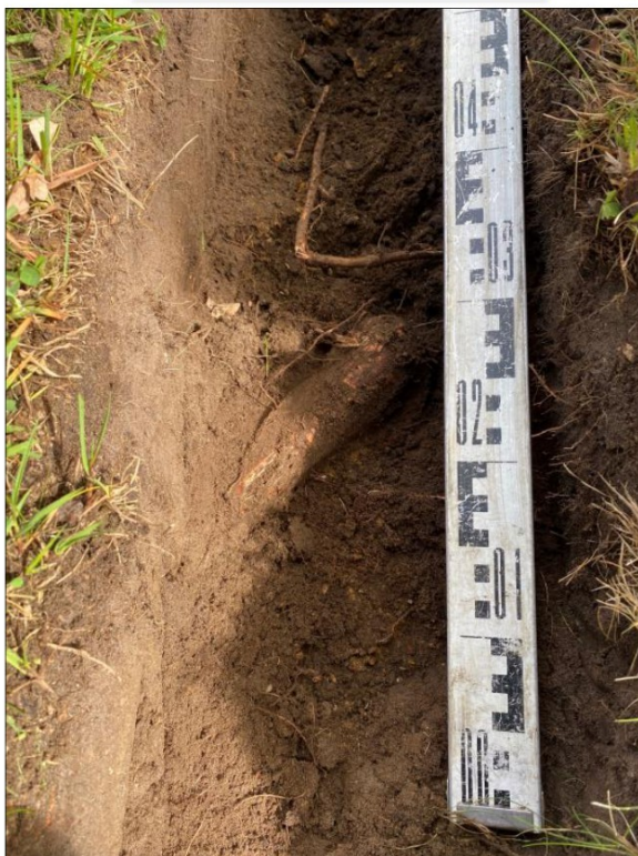
Afbeeldingen 16 en 17: Proefsleuf ter hoogte van de voorgenomen ontgraving (paars) bij boom 3. Op ca 15 cm-mv bevindt zich een aan de stabiliteit bijdragende wortel ( \varnothing 5).
