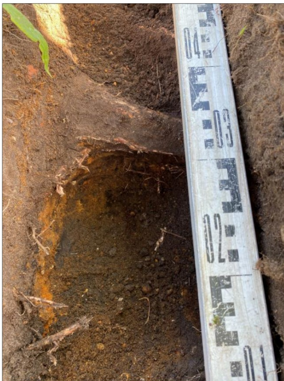
Afbeeldingen 11-13: Proefsleuf ter hoogte van de voorgenomen ontgraving (paars) bij boom 1. Op ca 20 cm-mv bevindt zich een aan de stabiliteit bijdragende wortel ( \varnothing 5 tot 7 cm).
