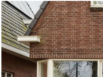
Beperkte gootomloop kopgevel
