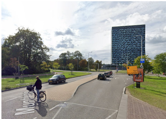
Overrijdbare middengeleider op de Muntweg. Hulpdiensten kunnen het autoverkeer bij het kruispunt passeren. (foto: googlemaps)
