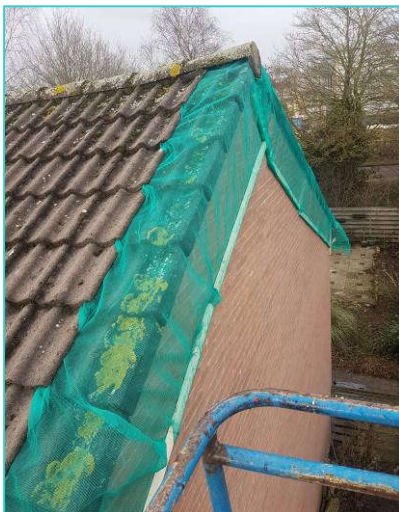
Figuur 2: voorbeeld exclusion flap op kopgevels.
