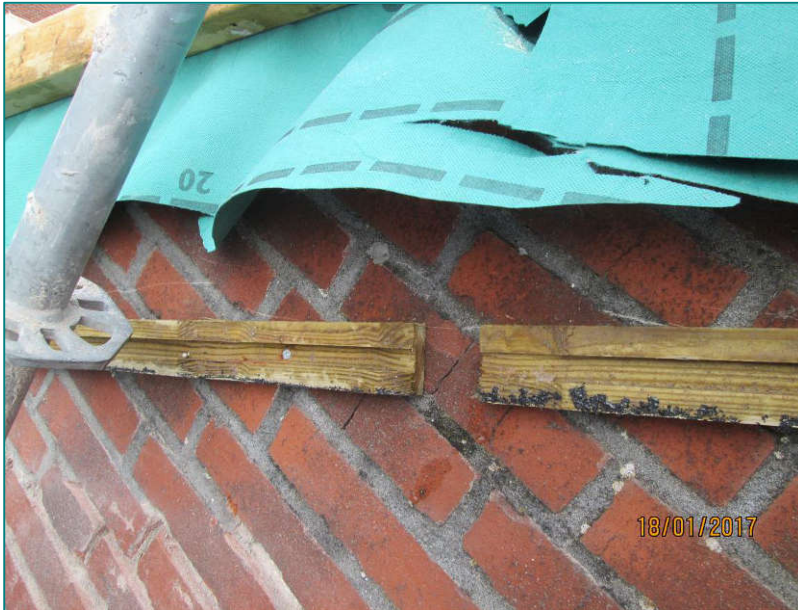
Figuur 6: Muurlatten voor bevestiging trespas boeibord met opening voor toegang vleermuizen achter boeibord. Folie wordt weggesneden.
