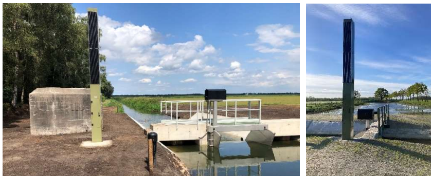
Figuur 9: voorbeeld van een geautomatiseerde stuw op basis van solar (Flow Drive)
