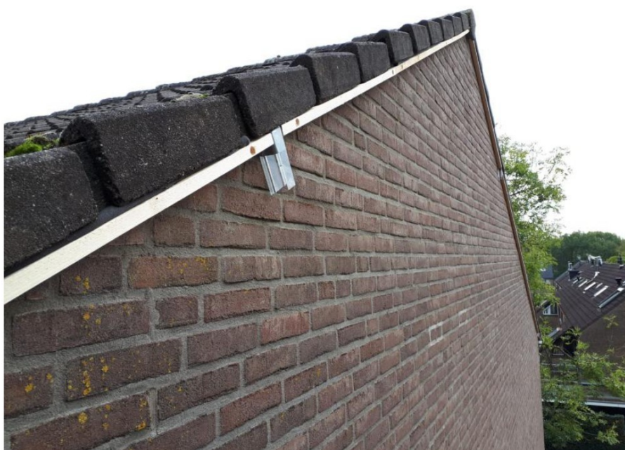
Detail exclusion flaps met panlatten en rugvulling.
