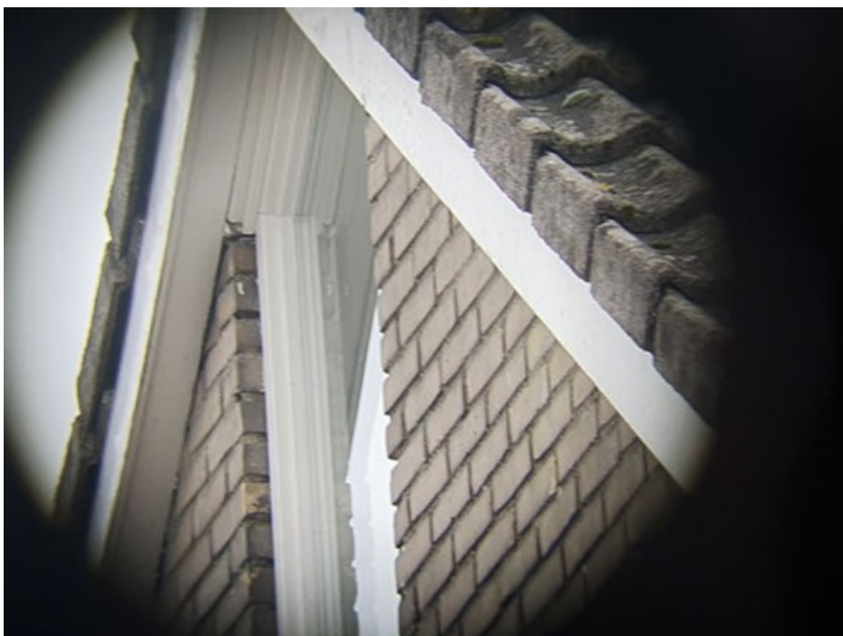
10: Ruimte onder het overstek en onder kantpannen.
