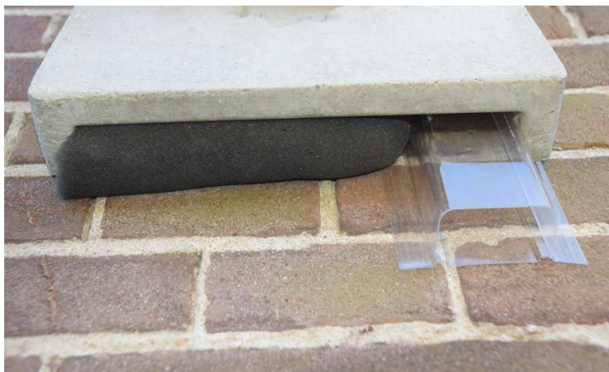
Muurschaal met exclusion flap en verder afgesloten met rugvulling.
