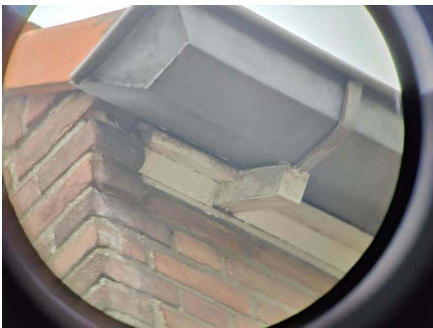
Foto 11: Ruimte bij de aansluiting van de goot.
