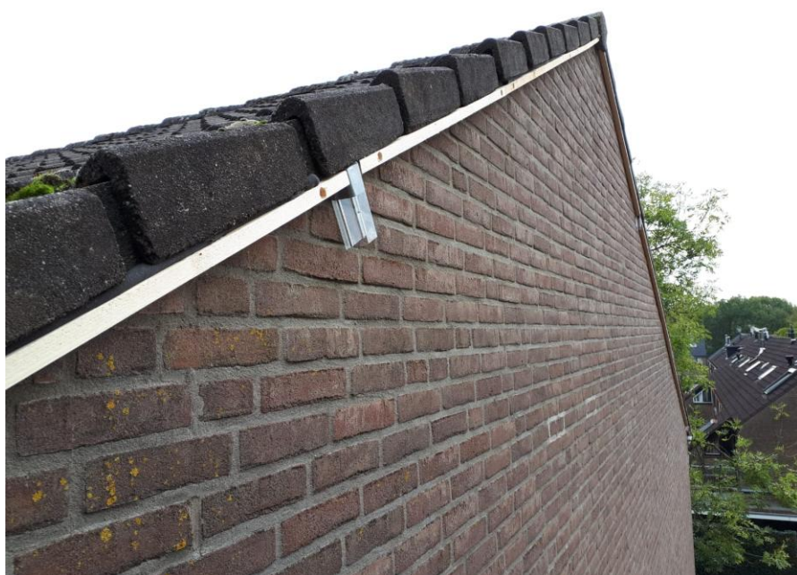
Detail exclusion flaps met panlatten en rugvulling.
