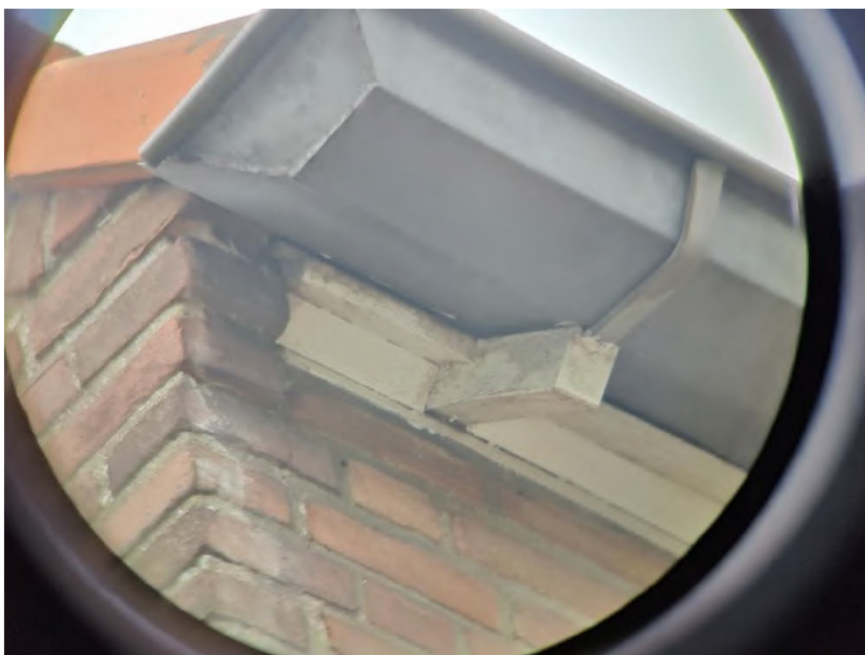
Foto 11: Ruimte bij de aansluiting van de goot.
