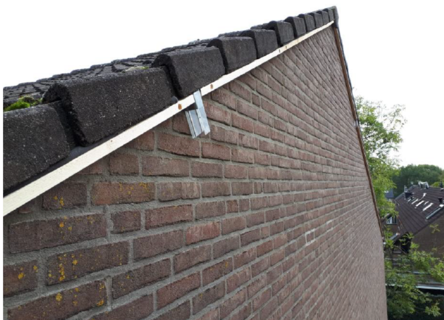
Detail exclusion flaps met panlatten en rugvulling.
