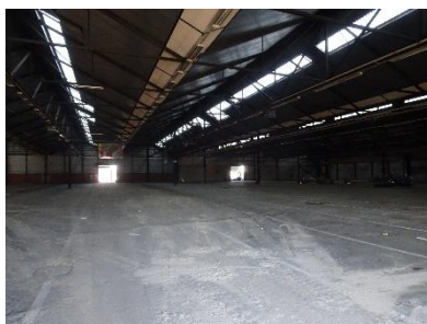
Figuur 2.4. Overzichtsfoto binnenkant te slopen deel.
