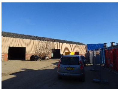
Figuur 2.3. Overzichtsfoto te slopen bebouwing.
