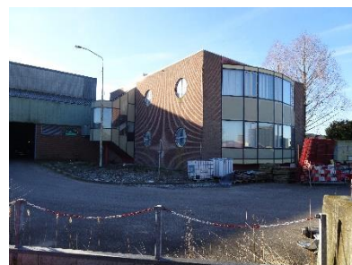
Figuur 2.5. Overzichtsfoto te slopen bebouwing.
