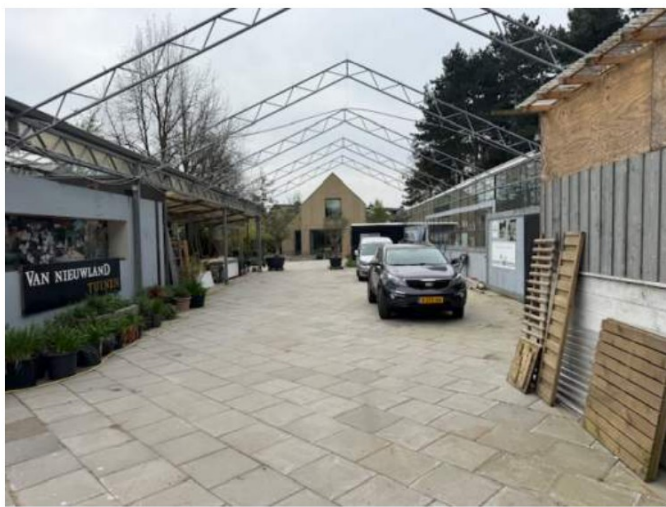
gebouwde houten woning op achter terrein
