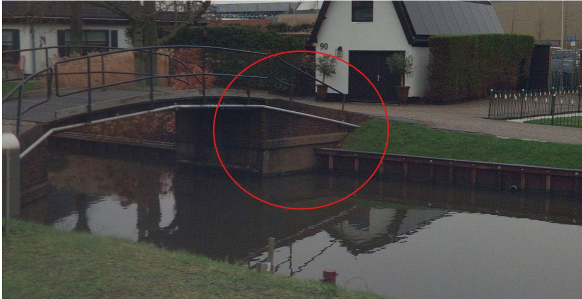
Figuur 3, Ontwerp-leggerwijzigingskaart LEGGER2026-01, de aangebrachte oeverconstructie stopt bij de brug.
