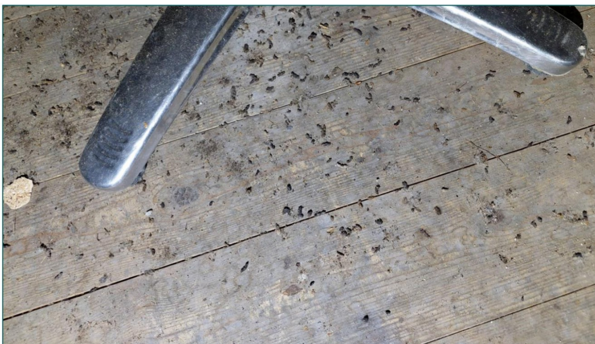
Figuur 2 Op de zolder van het koetshuis waren vele keutels en resten van afgebeten vleugels van nachtvlinders aanwezig. Hierdoor behoren deze tot de gewone grootoorvleermuis welke hier ook aangetroffen is.
