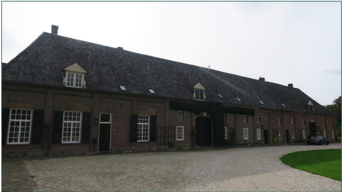
Figuur 1.3 Op de planlocatie is men voornemens om de daken van het hoofdbouwhuis en linker bouwhuis (foto) te renoveren.
