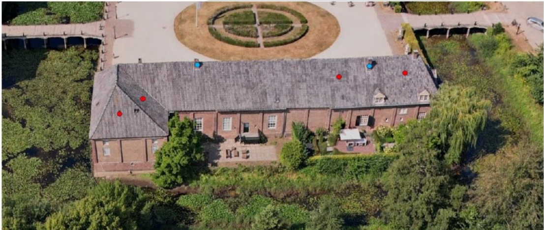
Figuur 4: Locaties van de invliegopeningen via schoorsteen (blauw) en aangepaste dakpannen (rood).
