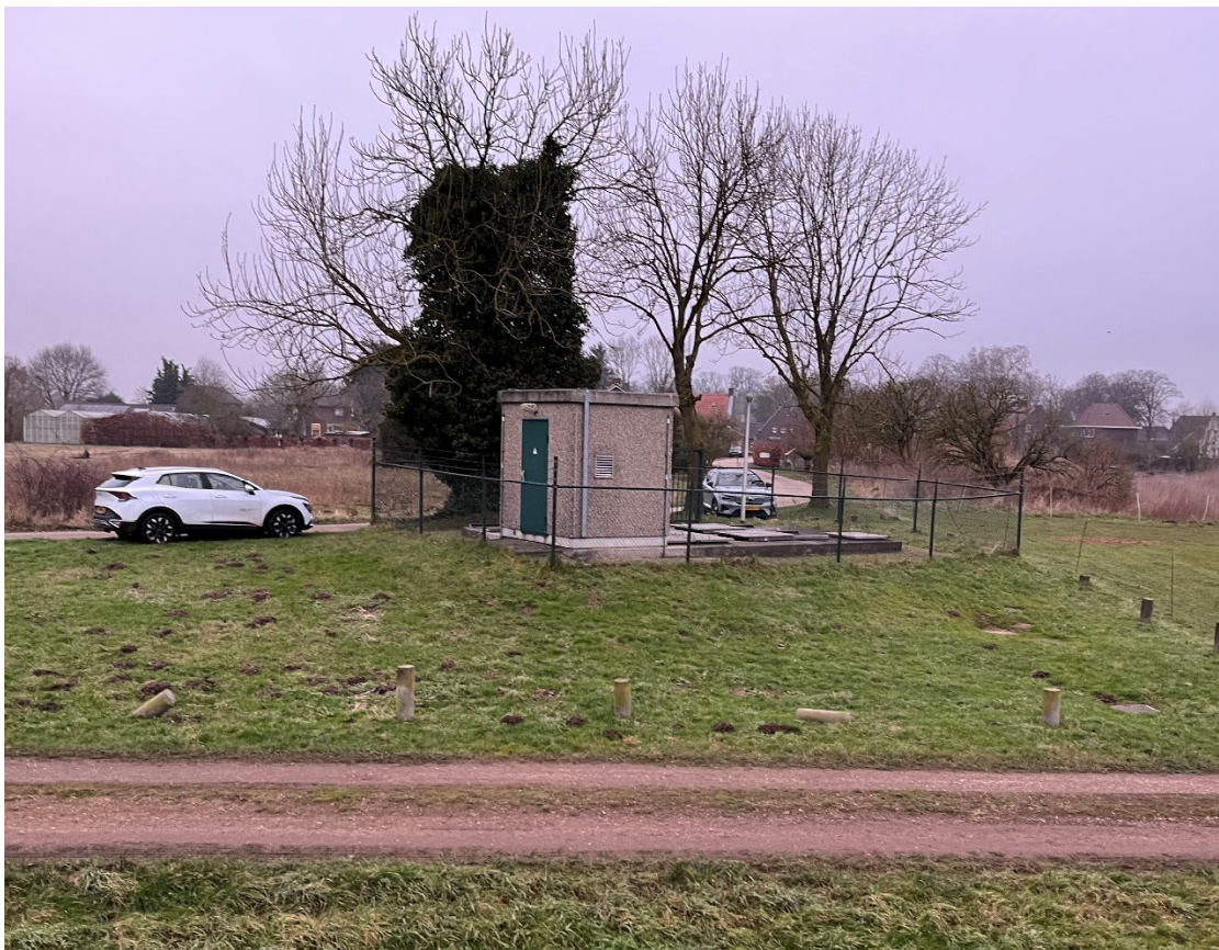
Foto 1: huidige rioolgemaal Well
