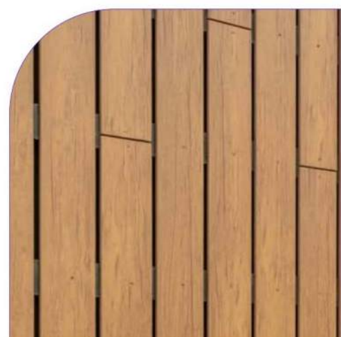
verticaal hout, thermisch gemodificeerd, fraké of vuren. planken in mm; 28 dik breed 200 - 40 tussenruimte
