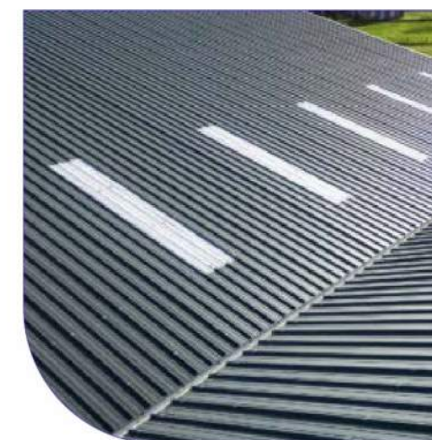
lichtcasseten in dakpaneel
