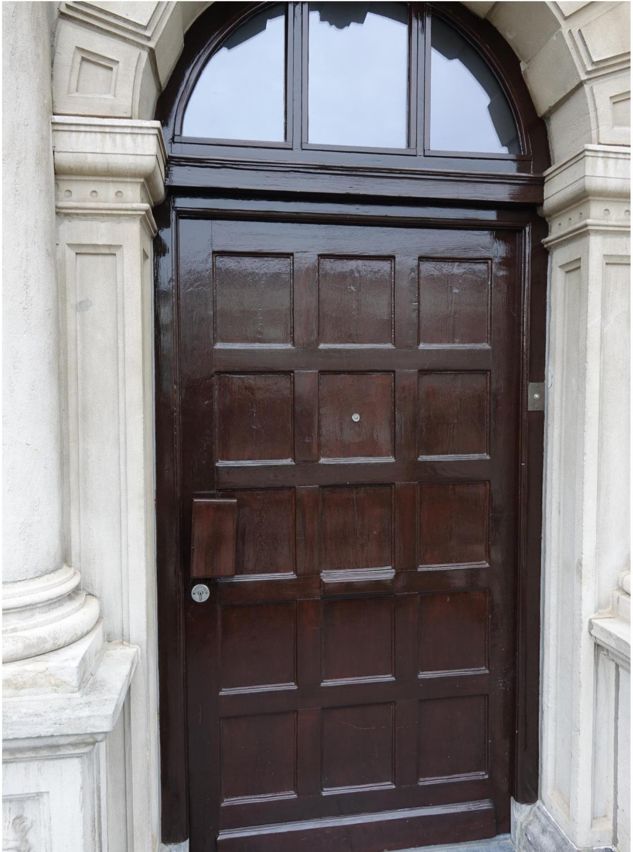
Figuur 16 Deurkozijn in goede staat
