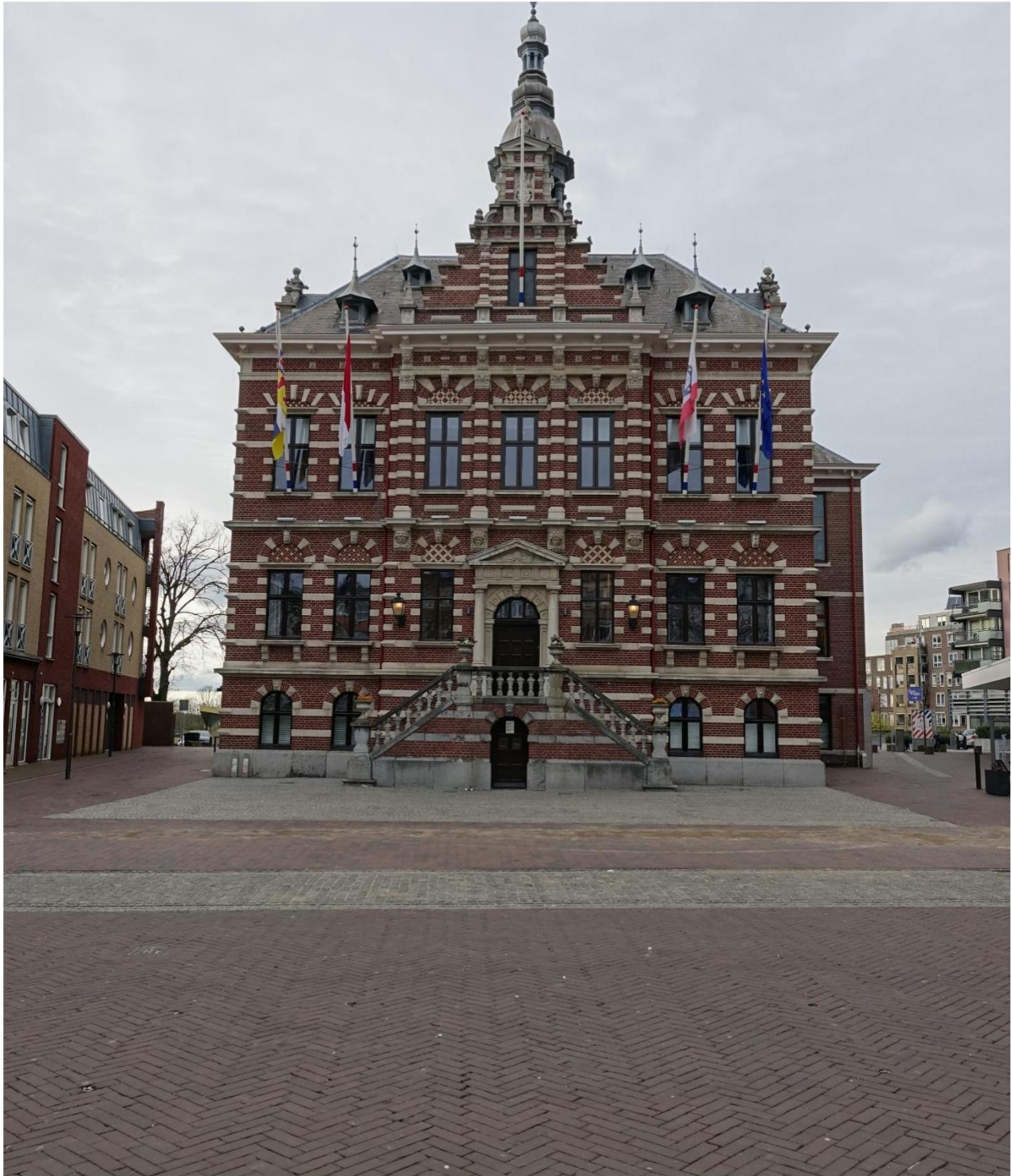
Figuur 1 Overzicht foto voorgevel
