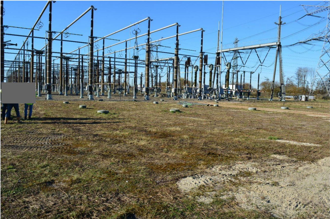
Figuur 1 Transformatorveld bestaande palen
