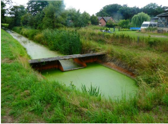
Afbeelding 2. Stuw 97958 gelegen in een watervoerende watergang.
