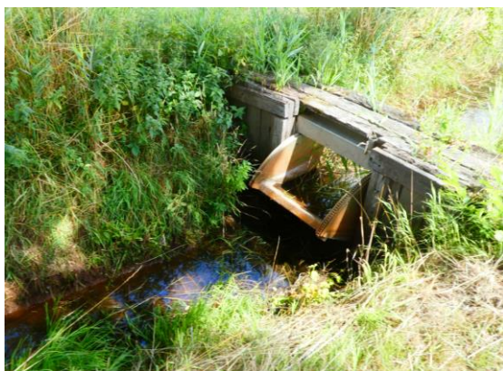
Afbeelding 17. Stuw 96918 gelegen in een watervoerende watergang.
