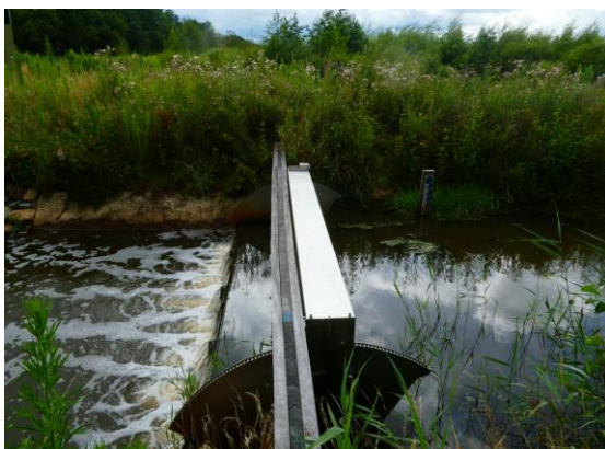
Afbeelding 7. Stuw 179292 gelegen in een watervoerende watergang.
