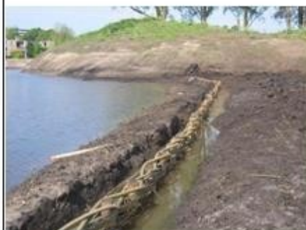
soort beschoeiing: paalwiepenbeschoeiing functie: tijdelijk behoud doorstroomprofiel
